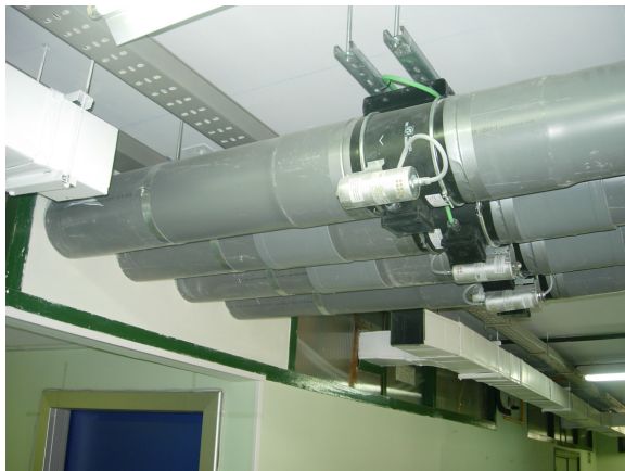
Extractores colocados en el Departamento de Zoología y dependencia de nueva construcción en la azotea de la Facultad de Biología para el almacenamiento de colecciones conservadas con sustancias tóxicas.
